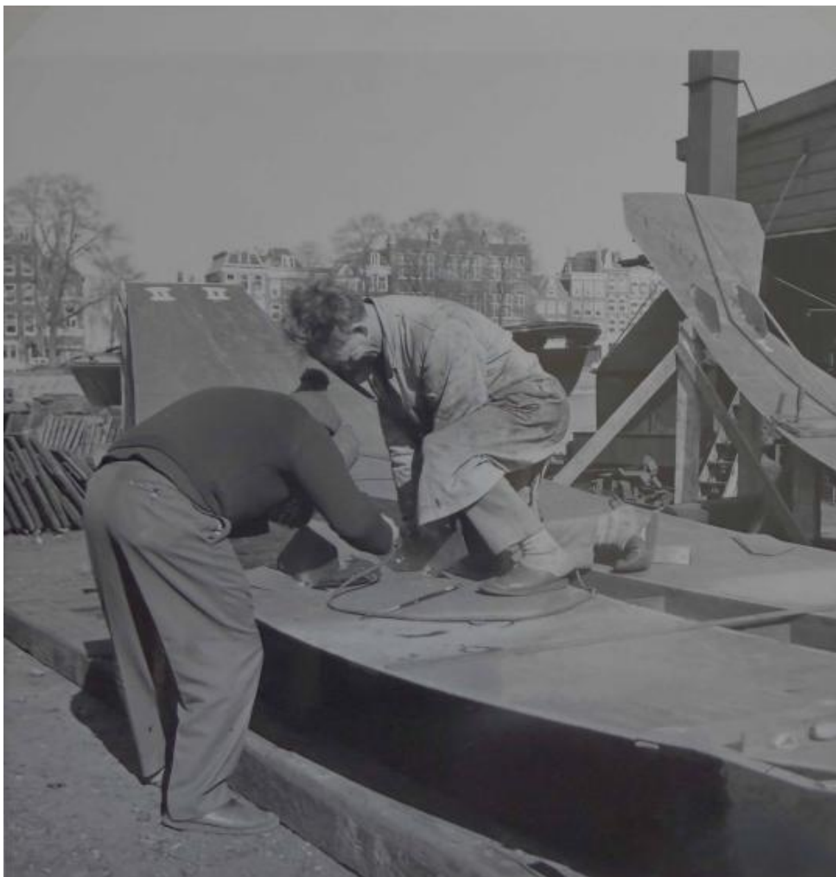
Ben (links) en Jan (rechts) lassen de kielbalk aan de grondplaat.
