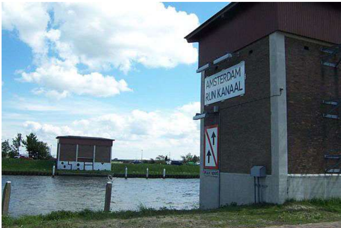
Schuivenhuisjes sifon langs Amsterdam-Rijnkanaal
