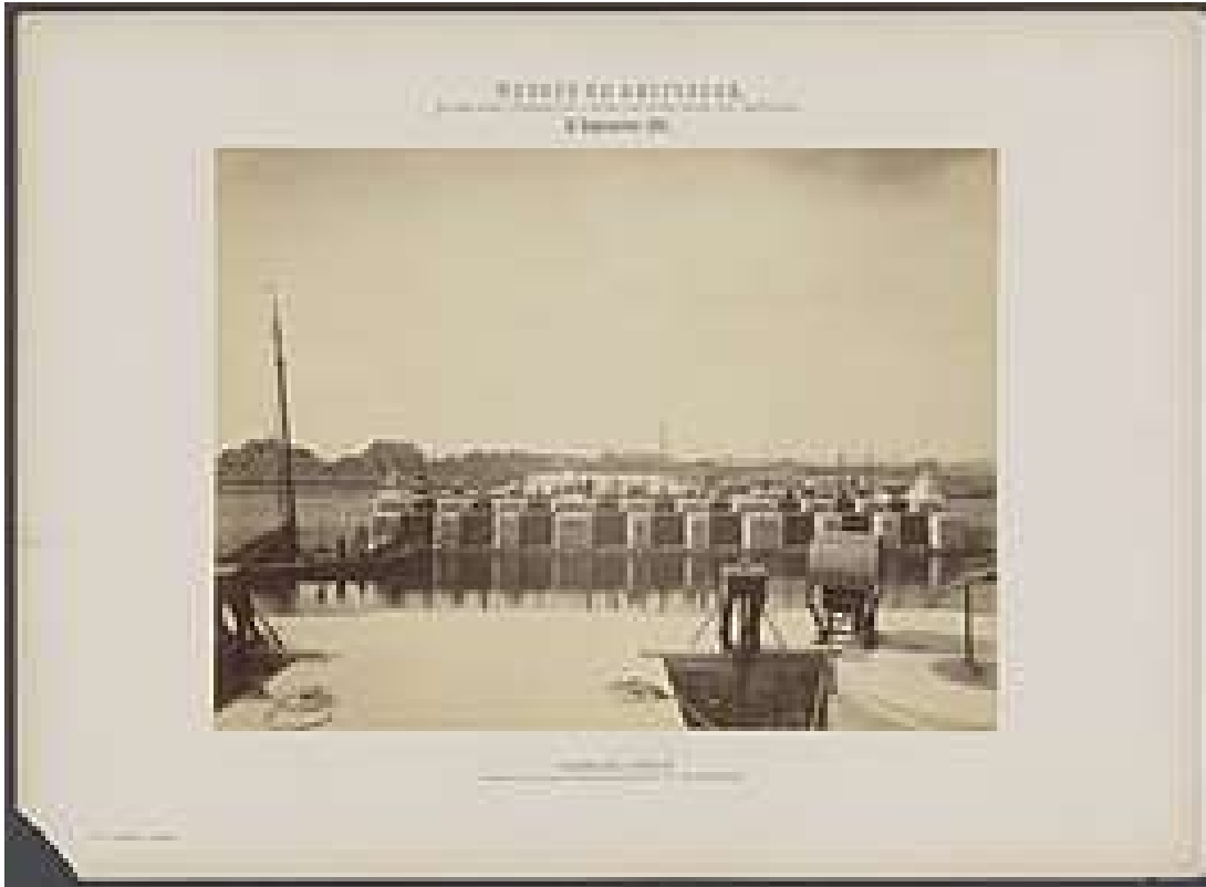
“Syphon Merwedekanaal nabij Zeeburg tot lozing van stadswater van Amsterdam; gezicht op het binnensyphonhoofd, genomen vanaf het buitenhoofd (1891)”
