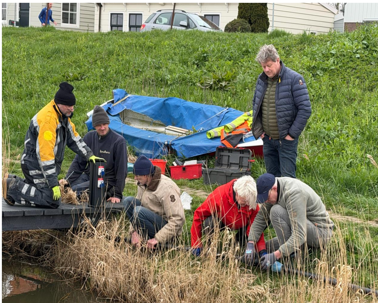
Leidinggevende Stephan (2 e van links) kijkt tevreden toe hoe de kabelbuizen worden gekoppeld.
