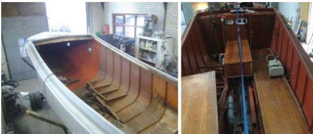
Eerste fase: lassen en boot in grondverf zetten. Daarna inbouw van de motor- en irokopanelen.
